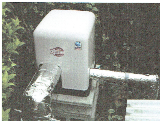
交換した新しい井戸ポンプ
