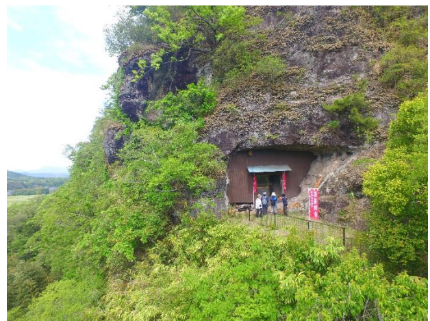
山腹にある岩屋観音堂（房常さんドローン撮影）
