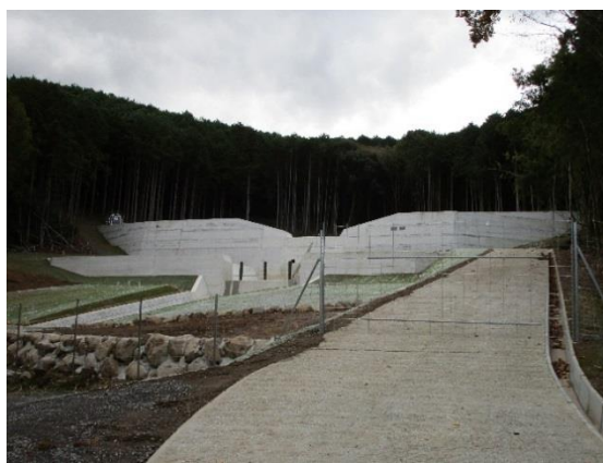
主えん堤は高さ7m・長さ100m 捕捉土砂量 1,096 m 3
